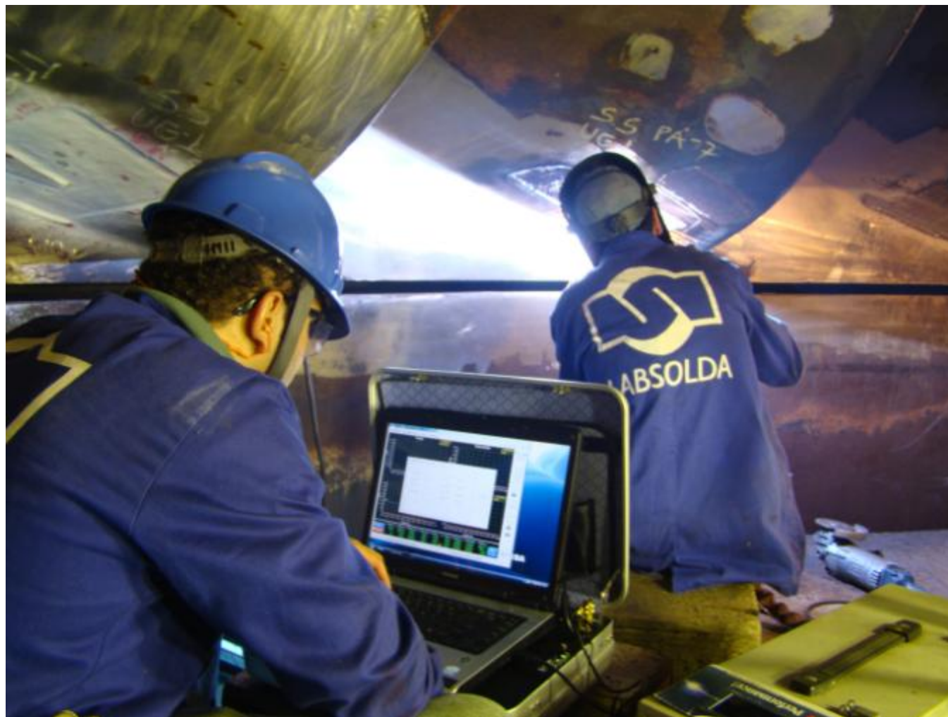
Aplicação de tecnologia PTA-P em Regiões de Turbinas Hidráulicas Sujeitas à Erosão por Cavitação
