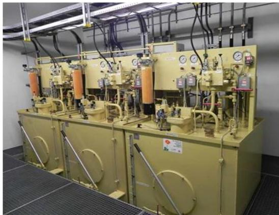
Figura 16. Unidade hidráulica de potência na Usina hidrelétrica de Langkampfen (Austria)
