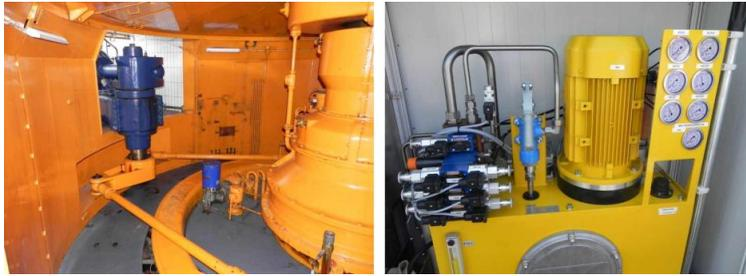
Figura 15. Sistema hidráulico usando fluido biodegradável. a) Servomotor do regulador de velocidade; b) Unidade de potência das comportas
